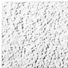
Така минерална мазилка с драската структура. Обформането на повърхностната структура се получава чрез внимателно пглане на част от каловестата чрез драскане с дъска с набити в нея нирани иза с твърда четка
